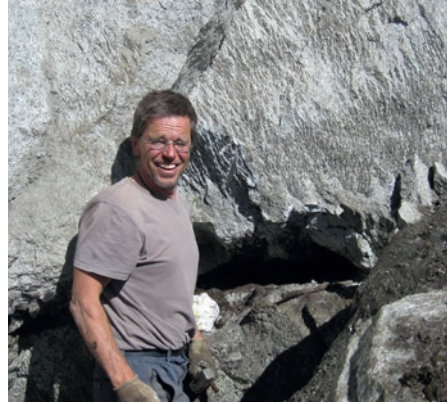
Nach dem Entfernen der dicken Eisschicht ist endlich ergonomisches Arbeiten an der oberen Kluft möglich.
